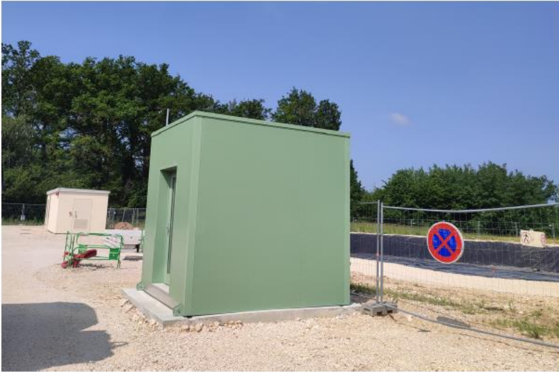
Local supervision en place
