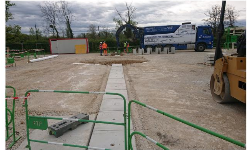
Installation caniveaux techniques (réseaux MSP et électriques)
