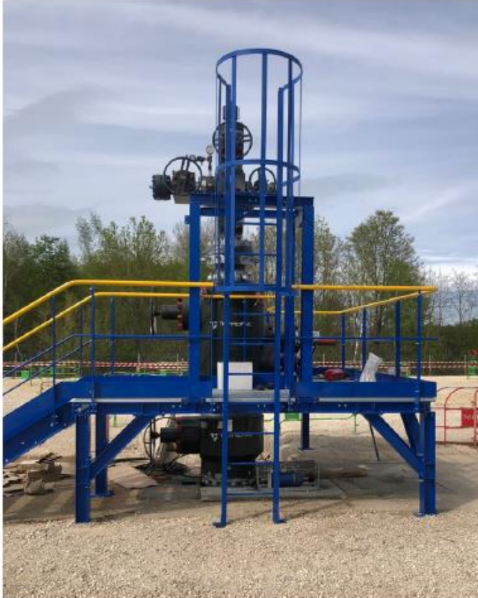
Installation passerelle accès Tdp
