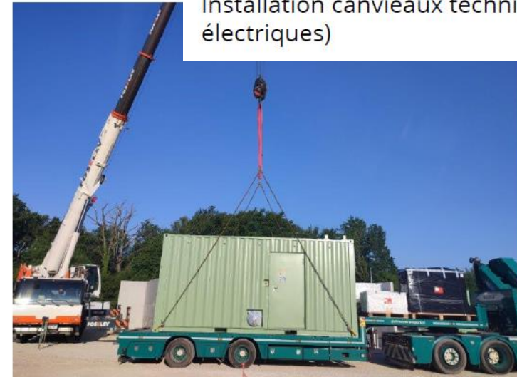
Levage compresseur
