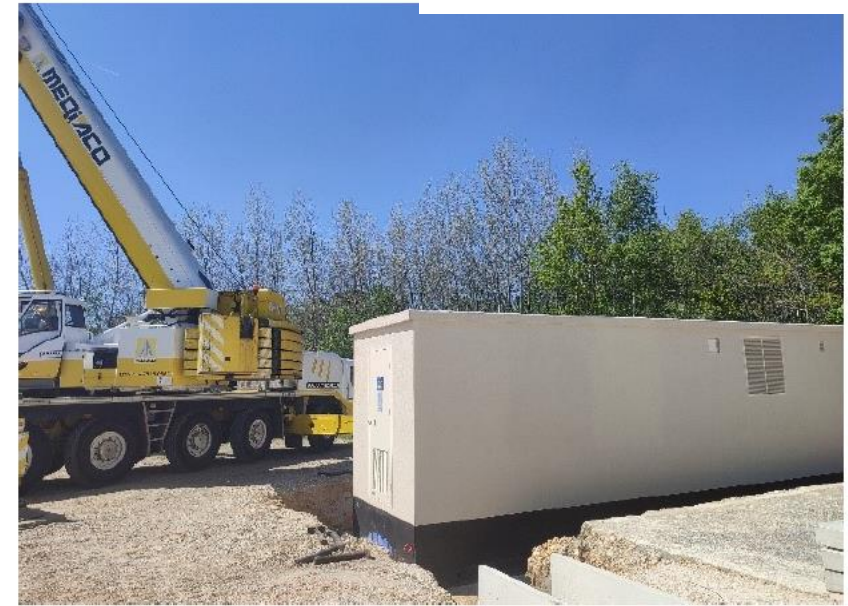
Installation nouveau poste électrique
