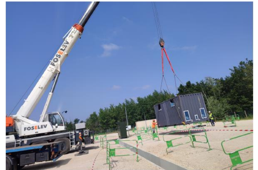
Levage skid saumure
